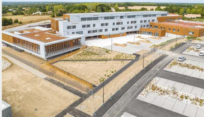
L'architecte CRR Ecritures Architecturales, sous l'impulsion de la Région des Pays de la Loire, a imaginé un lycée à la pointe. Paradoxalement, il a également démontré que « sobriété » peut être étroitement liée à « modernité » et « confort » au travers d'une conception bioclimatique bois, paille et chanvre. Il s'agit d'ailleurs du plus grand chantier d'Europe en construction paille (18 000 bottes de paille).
